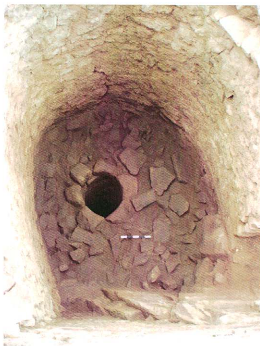
Kagenfels ; citerne, située dans la tour palière. Vue d'ensemble sur le matériau filtrant ; le puisard est désaxé vers le sud
