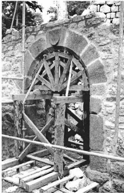
Kagenfels : restitution de la porte PB avec ses claveaux d'origine ; le niveau de reprise des parements a été marqué par des fragments discrets de tuiles plates. Juin 2003
