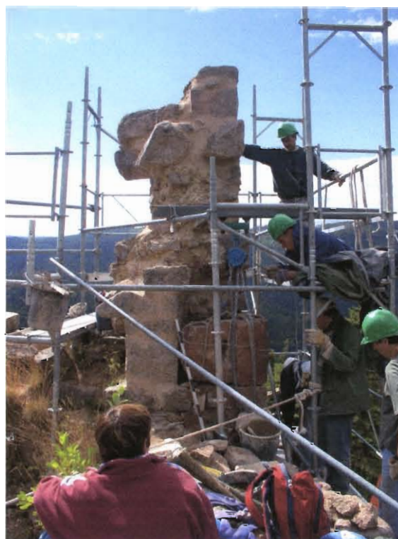
Kagenfels : pose de la base de la porte de latrines, visible sur la photo de 1931. Été 2004
