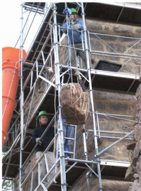
Kagenfels : levage du bloc de base de l'encadrement de porte de latrines, mur L5, niveau 2, retrouvé dans le fossé nord hors sol (bloc inv.LPN1)
